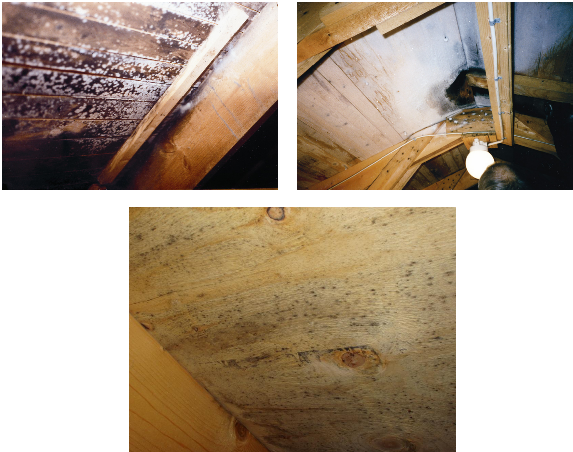
Figur 1. Exempel på olika fuktskador
